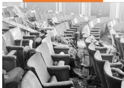
演播厅吊顶脱落
